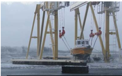
↑ 海陽ではクレーン下の栈橋が高潮で 浮上がり野積み場に打ち上げられた。 沖堤を超える大波も写っている。
