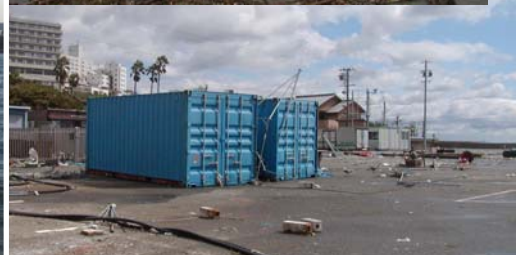
←旧蒲郡ハーバー、中央栈橋は高潮で杭から抜けた。 MCCコンテナは高潮で浮き移動してしまった。↑
