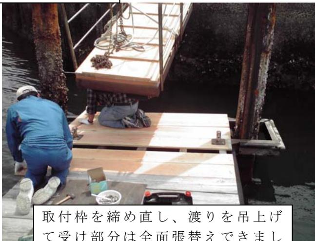
取付枠を締め直し、渡りを吊上げて受け部分は全面張替えできました。
