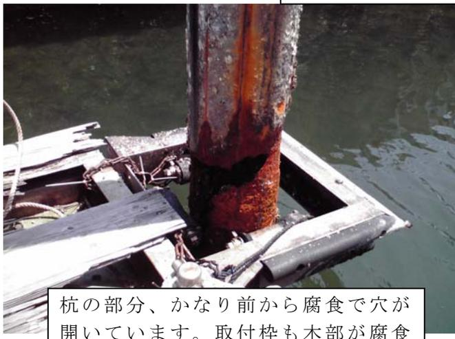
杭の部分、かなり前から腐食で穴が開いています。取付枠も木部が腐食しガタガタでした。
